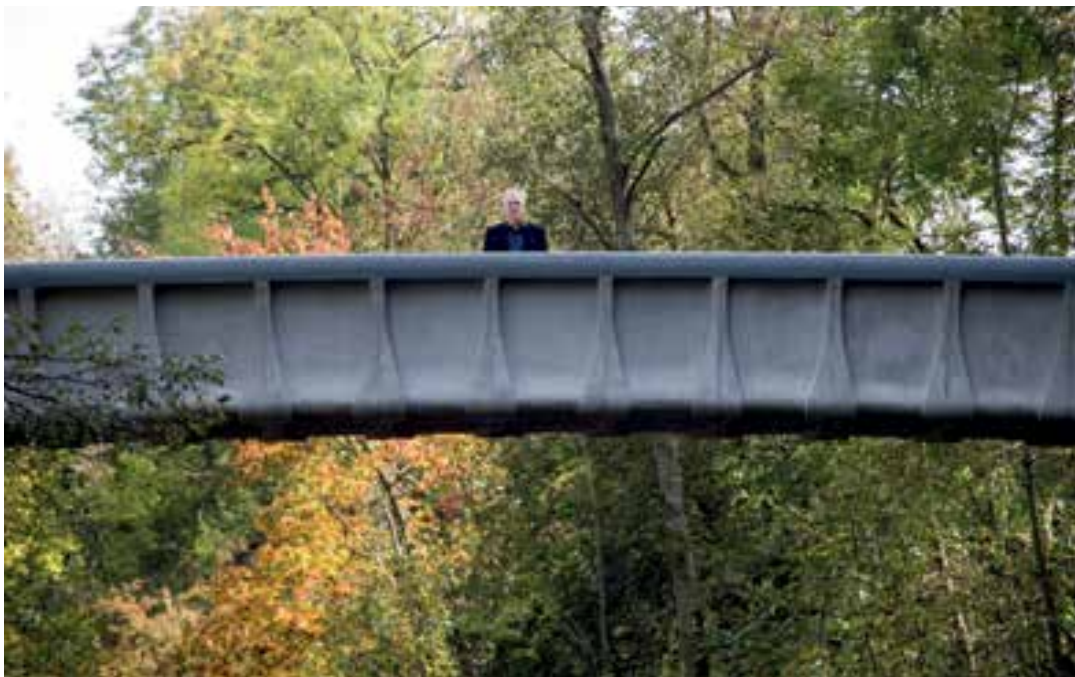
3 Zweite fertiggestellte Brücke in Kempten © Harald Michler
