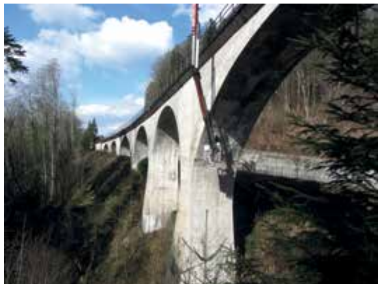
Zustandserfassung am Laufenmühle-Viadukt © Karlsruher Institut für Technologie
