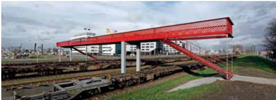
1 Waalhafenbrücke in Rotterdam nach Fertigstellung © ipv Delft
