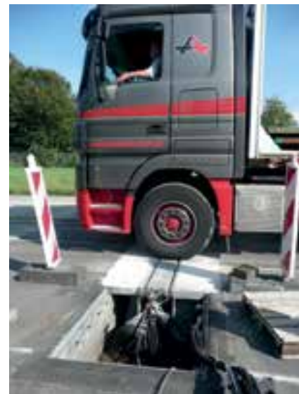
■ Verbreiterte Lamelle der neuen Fuge © Maurer SE
