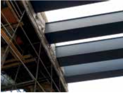
Langenfelder Brücke in Hamburg im Bauzustand © Hempel (Deutschland) GmbH
