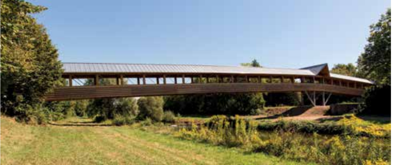
1 Heutige Geh- und Radwegbrücke in Lörrach © Markus Ruf
