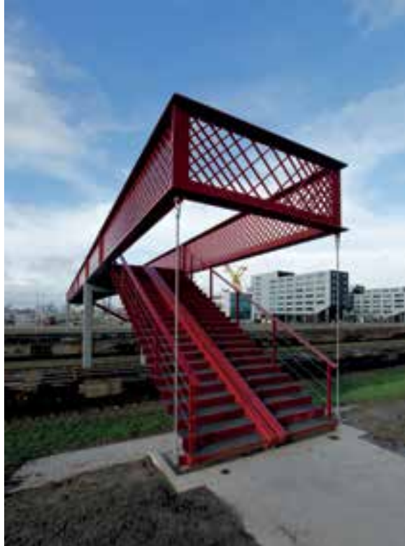
7 Östlicher Treppenaufgang mit Fahrradrinne und Auskragung © ipv Delft
