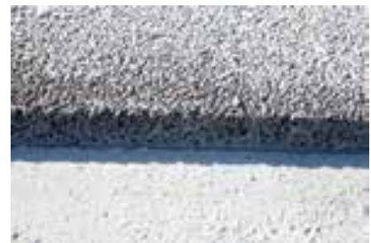
Fahrbahnbelag aus zwei Schichten © Leonhard Weiss GmbH & Co. KG
