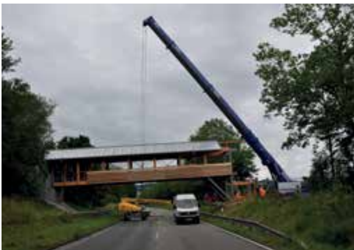
18 19 Montage von erstem und drittem Segment © Schmees & Lühn Holz- und Stahlingenieurbau GmbH & Co. KG
