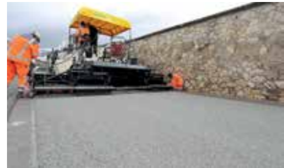
Einbau mit einem Fertiger © Sika Deutschland GmbH
