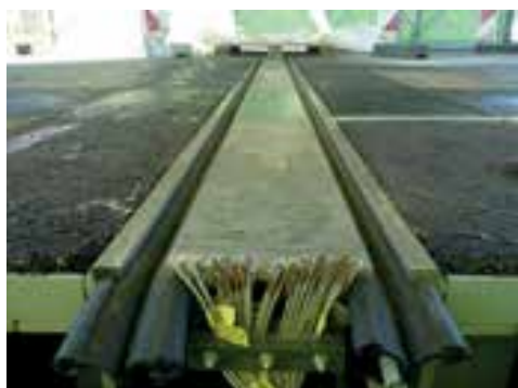
■ Teststand: Schwenktraversen-Dehnfuge © Maurer SE
