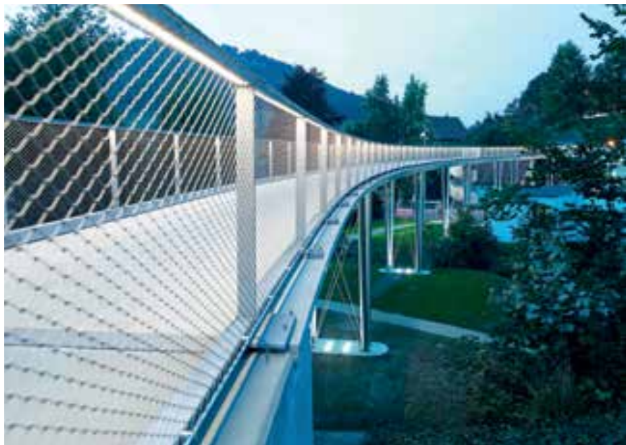
4 Weltweit längste Textilbetonbrücke in Albstadt © solidian GmbH
