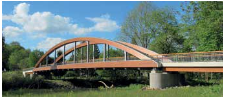
■ Holzbrücke über die Agger in Höngesberg © Fachhochschule Erfurt
