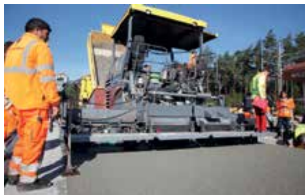
Herstellung mittels Straßenasphaltfertiger © Leonhard Weiss GmbH & Co. KG
