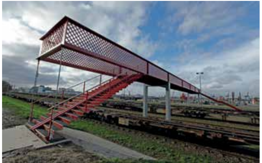
9 »Schwebende« Treppenkonstruktion über dem Erdwall © ipv Delft
