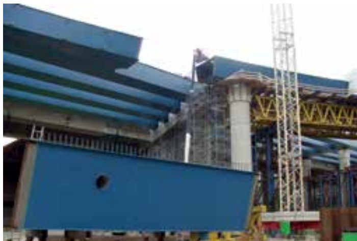
Montage der Talbrücke Dorlar © Hempel (Deutschland) GmbH
