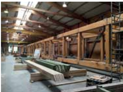
15 16 Überprüfung und anschließende Verladung des Brückenzugs © Schmees & Lühn Holz- und Stahlingenieurbau GmbH & Co. KG
