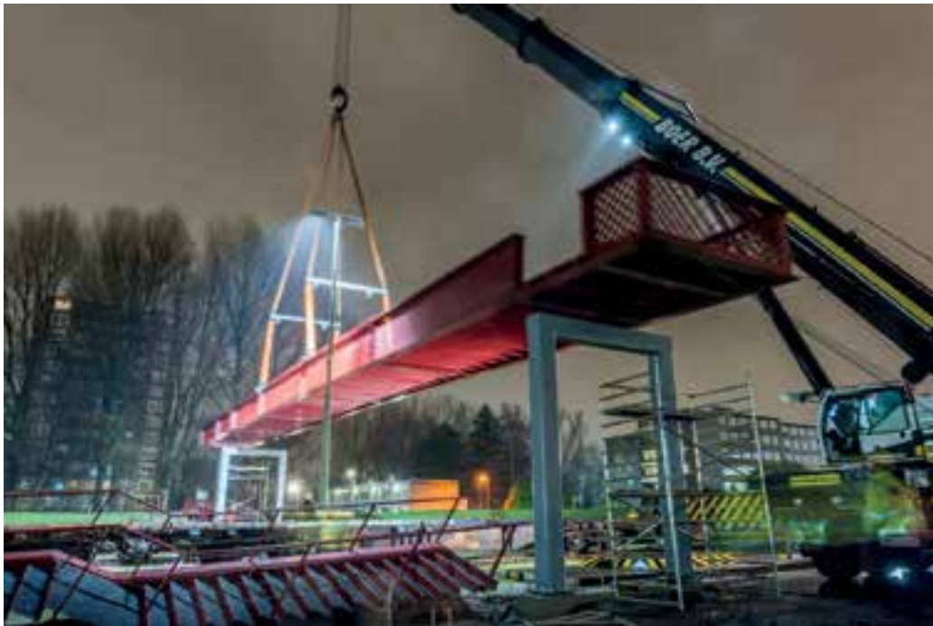
12 Montage: Einheben der Stahlstruktur © ipv Delft
