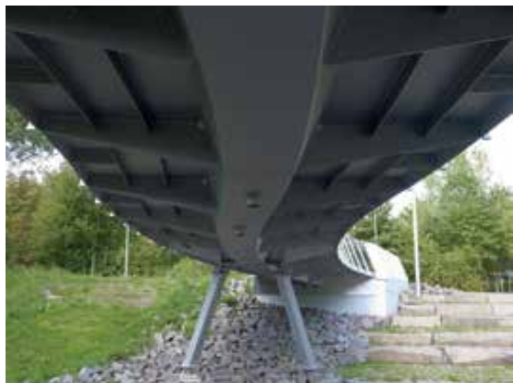
9 Kombination aus Hohlkasten und orthotroper Platte © Tom Gundelwein
